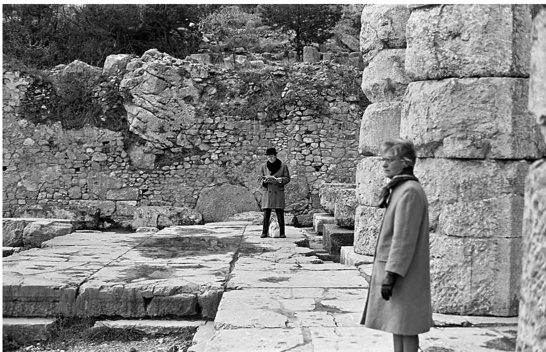
Fig. 8 : Moitié est du mur de soutènement au nord du temple, intégrant des rochers tombés.
