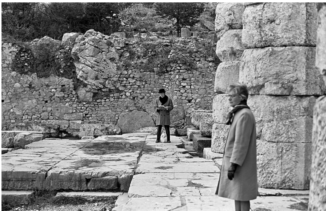
Fig. 8 : Moitié est du mur de soutènement au nord du temple, intégrant des rochers tombés.
