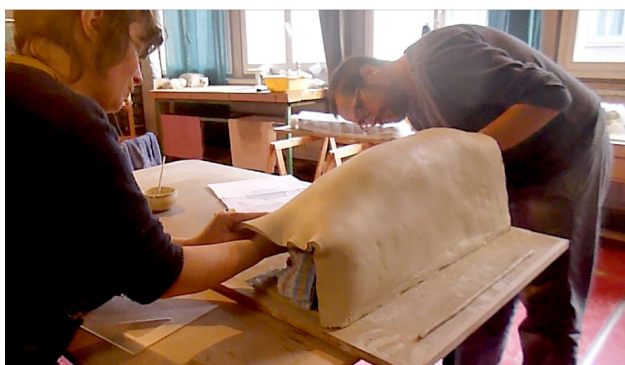
Figure 4 : façonnage des extrémités de la voûte déjà raccordée à la base sur les longs côtés.
